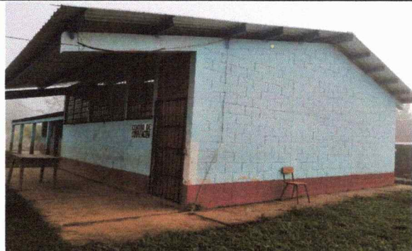
Foto 6: Se observa humedad y desprendimiento de la pintura en el módulo 3
