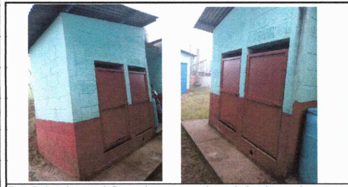
Foto 5: Se observa daños en las puertas y humedad en la paredes por deterioro módulo 6.
